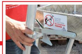
Vérifier le bon positionnement du crochet anti-soulèvement du plancher.
