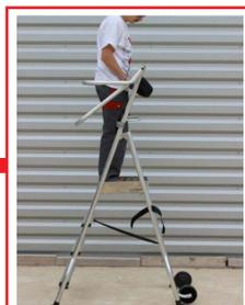
Avancer sur le plancher en robottant derrière vous le garde-corps.
