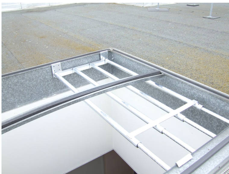
Grille de protection de lanterneaux positionnée et fixée
