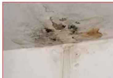
Exemple de dégât causé par la condensation au droit d'un potelet non isolé
