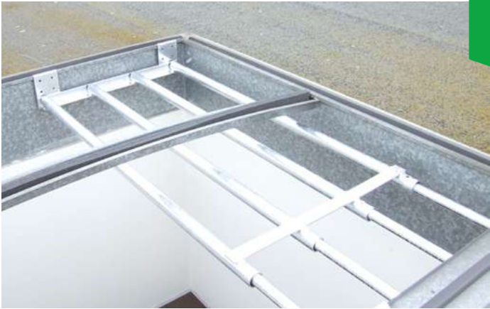
Grille de protection de lanterneaux positionnée et fixée
