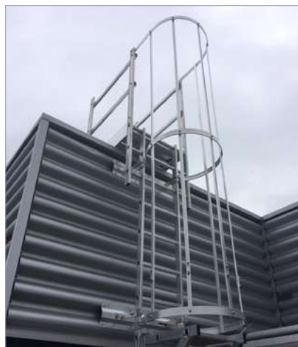
Échelle à crinoline petite hauteur en situation
