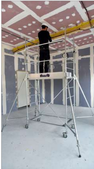
Hauteur plancher 1,70 m
