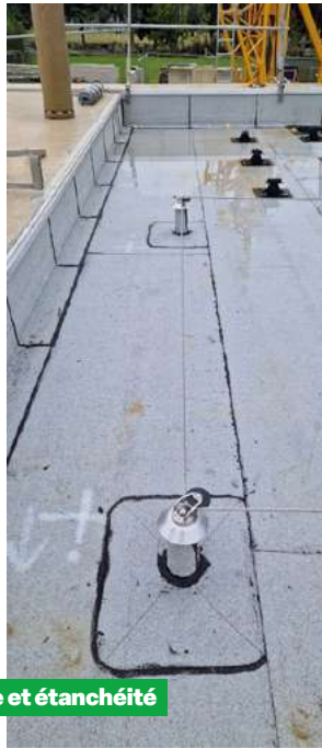
Passant sur joint debout
