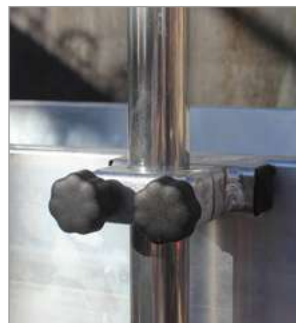
Molette de serrage pour mise en place des stabilisateurs
